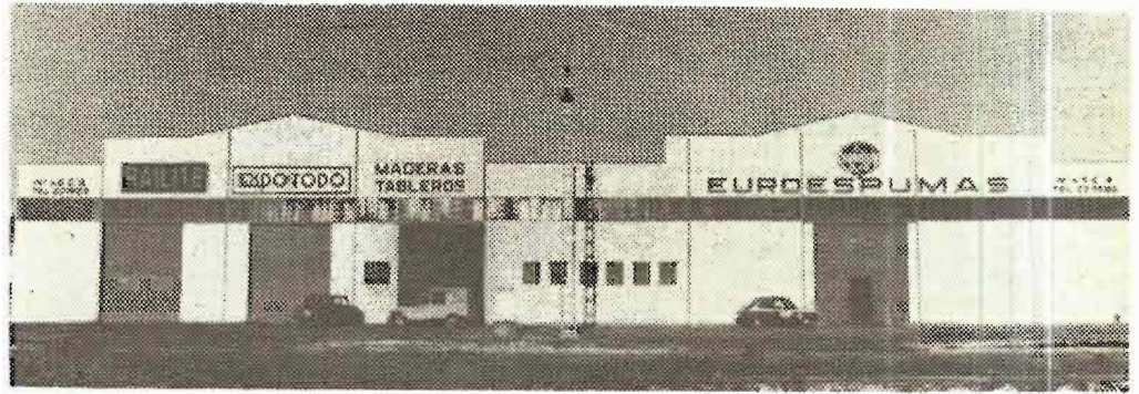
Las naves gemelas de transformación de tableros y poliuretanos, promovidas en "Campollano"
