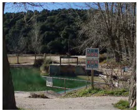
Azud que desvía los aportes de aguas superficiales hacia el baño de las mulas entre la laguna Tomilla y Tinaja
