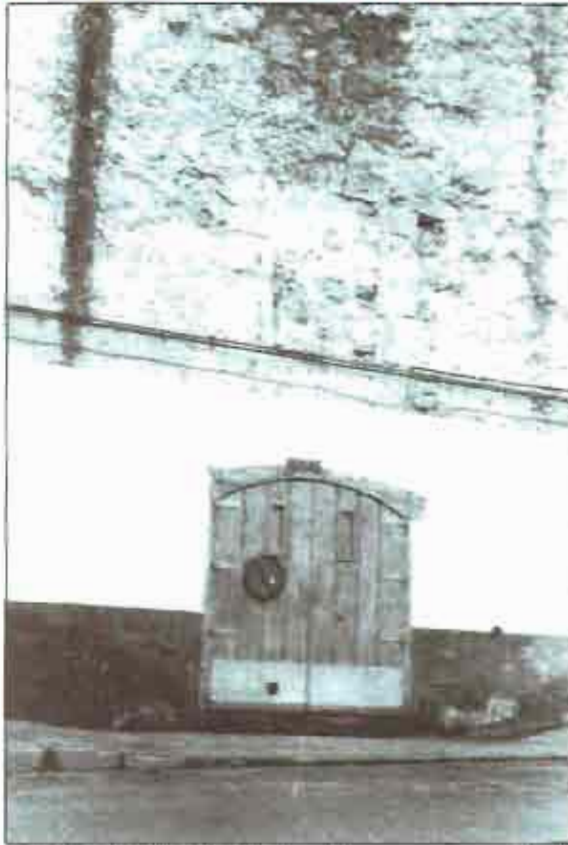
La puerta colocada sobre el muro del monumento, con la placa de prohibición de aparcar.
