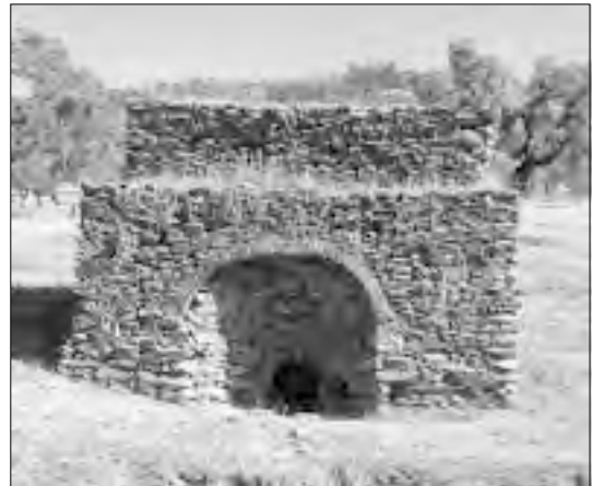
Foto 4. Horno en piedra seca en un cortijo onubense.
