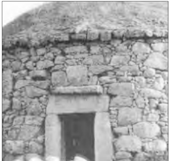
Fig.4: Detalle de visera por encima del dintel.
