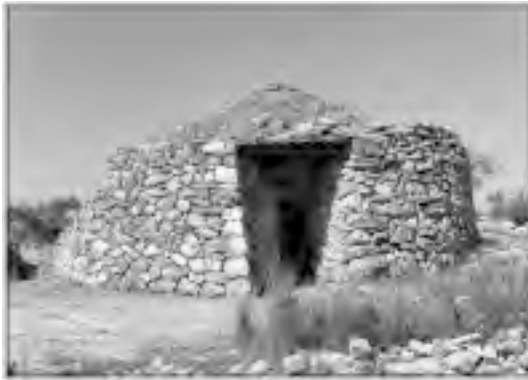
Foto 2.- Cuco de Pedro Sanchiz. Como los demás, está orientado al sur, previniendo los vientos fríos del norte, y mira hacia el pueblo, configurando una de las vistas más hermosas por su emplazamiento. En su interior encontramos un banco, una chimenea y una alacena, y en su exterior una poceta de un metro y medio de profundidad, sin duda para recoger el agua de lluvia. Su intervención ha sido muy intensa por la peligrosidad de derumbe en la parte frontal e izquierda.
