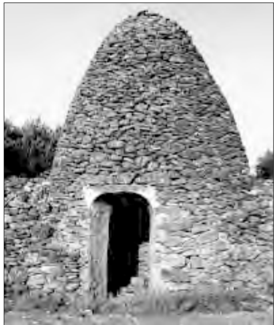
Foto 4.- Construcciones de planta circular
