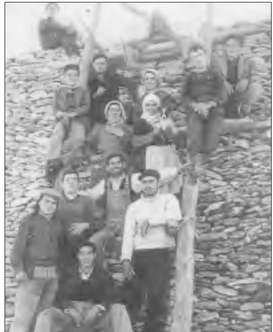
Construcción de un bombo en Villarrobledo, 1958.
