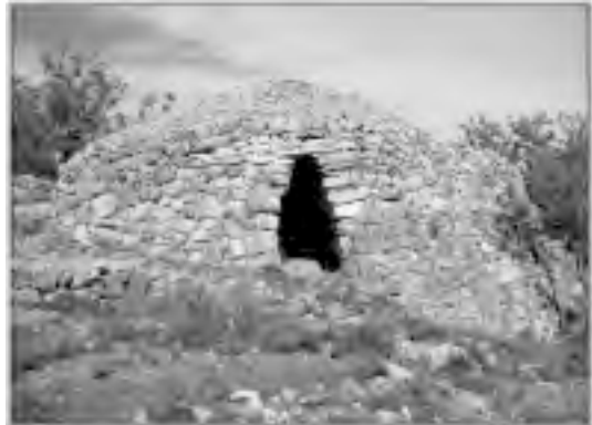
Foto 10.- Cuco de Manuel Abad. Está situado en Los Paraillos, en el seno de un barranco. Es sencillamente espectacular; debido al grosor de sus muros, alcanzando los dos metros largos, dando una sensación de seguridad y fortaleza importantes. Es toda una experiencia descubrirlo desde lo alto de las paredes del barranco, pues se confunde con el entorno. Como los demás cucos, fue necesaria su reconstrucción parcial.
