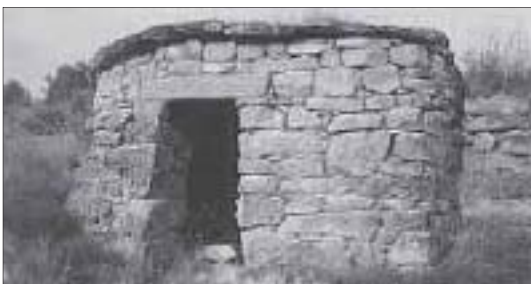
Cabaña cubierta por eliminación de ángulos
