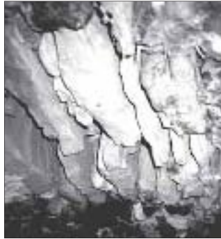
7.- Chozo. Aldeanueva de Ebro. Superior: Detalle bóveda corrida con lajas de arenisca trabadas "a seco". Inferior: Perspectiva del chozo.
