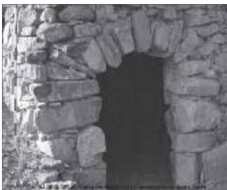
Lámina 8. Elementos constructivos en piedra seca.
