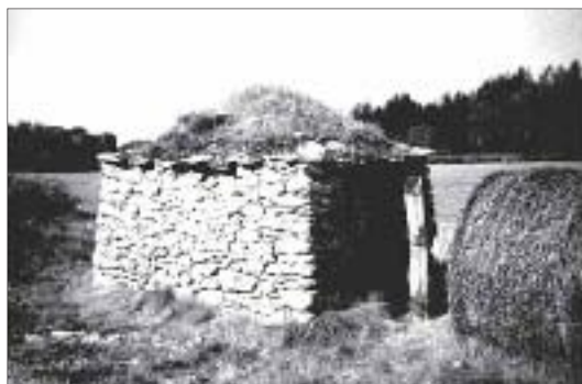
Foto 1. Barraca de planta cuadrada. En esta fotograf a puede apreciarse claramente el trabajo de confecci n del muro a base de piedras planas de forma irregular, colocadas sin ning n tipo de preparaci n previa. En las esquinas se colocan las piedras m s grandes para dar mayor solidez a la construcci n.(Calders – Bages)
