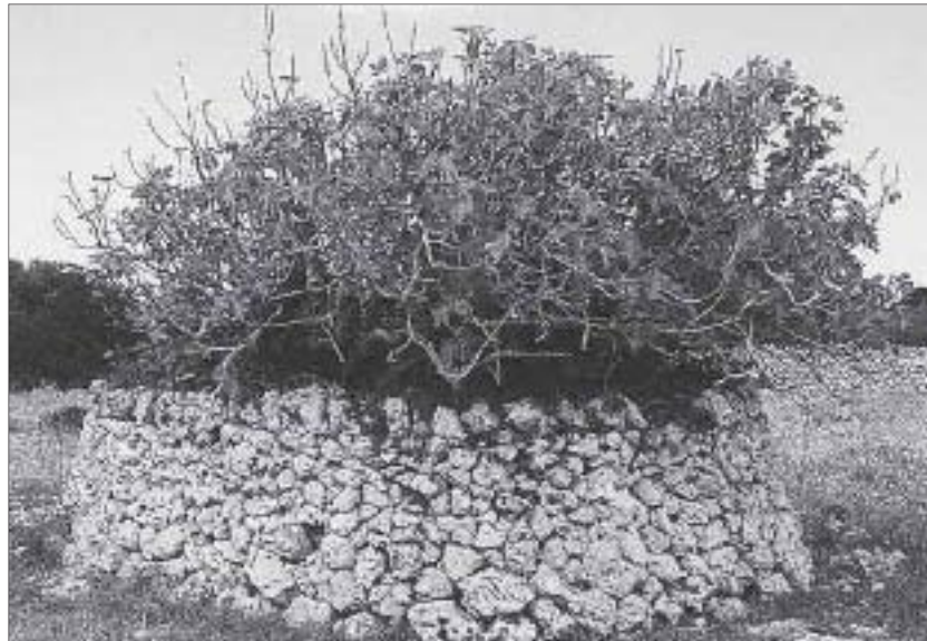
7. Ejemplo de un corral de dimensiones reducidas y de planta circular, que sigue la misma técnica constructiva que la paret seca utilizada para la parcelación del medio rural menorquín y que, en el presente caso, tiene como objetivo proteger una higuera del pasto del ganado.
