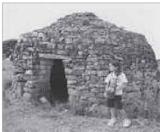
Cabanes cubiertas con falsa cúpula
