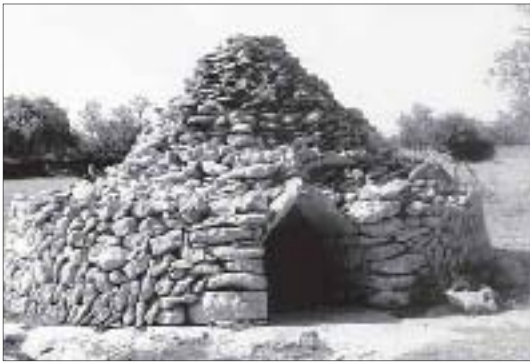
Foto 12.- “Bassa” con cubierta
