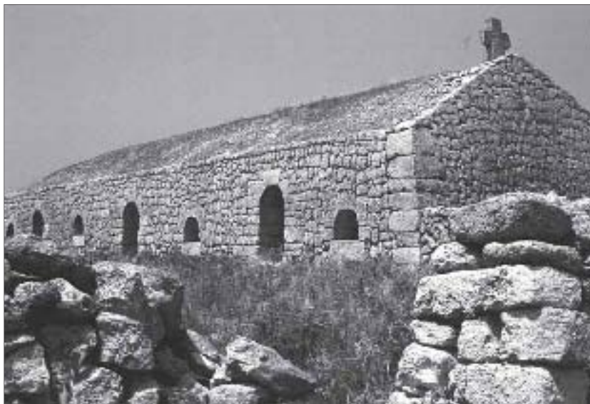
6. La aridez y la cantidad de piedra en superficie impulsó a los propietarios y payeses de las explotaciones de la zona norte del término de Ciudadella a dedicarse a la ganadería ovina intensiva, a la cual van destinadas sus construcciones en piedra seca. En la imagen se aprecia un pont en primer término, y dos barraques en el fondo.
