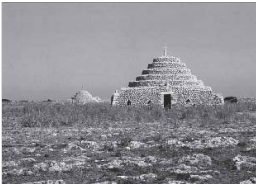
5. “Es pont de sa Creu”, en tierras de la explotación de Son Salomó (Ciudadella de Menorca). Se trata de un raro ejemplo de arquitectura en piedra seca con piedras perfectamente labradas y ensambladas y cubierta del espacio interior con bóveda de cañón.
