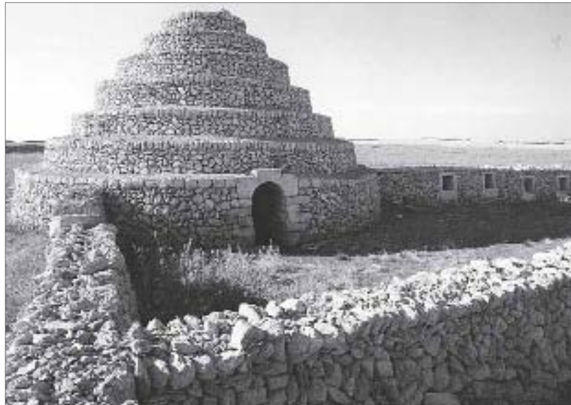
3. Característico entramado de paret seca de la isla, realizada con piedras sin desbastar y sencilla cubierta de piedras perfectamente encajadas, típica de los muros de las tanques destinadas a cultivo y pastoreo de la explotación menorquina.
