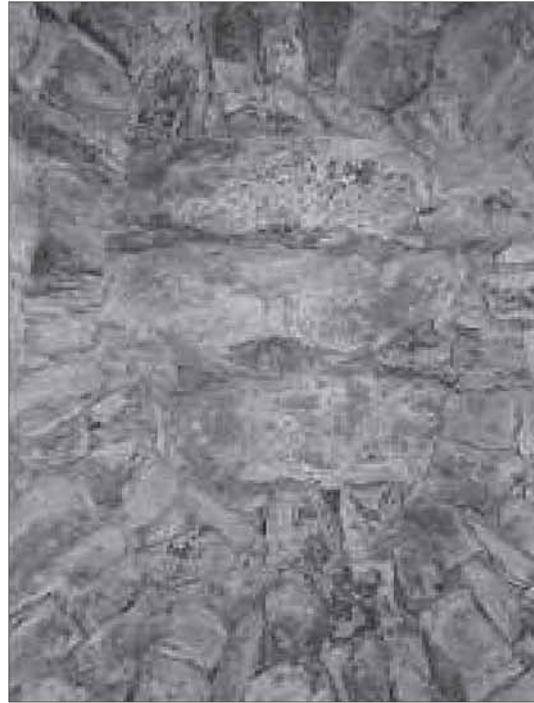
Cubierta de losas
