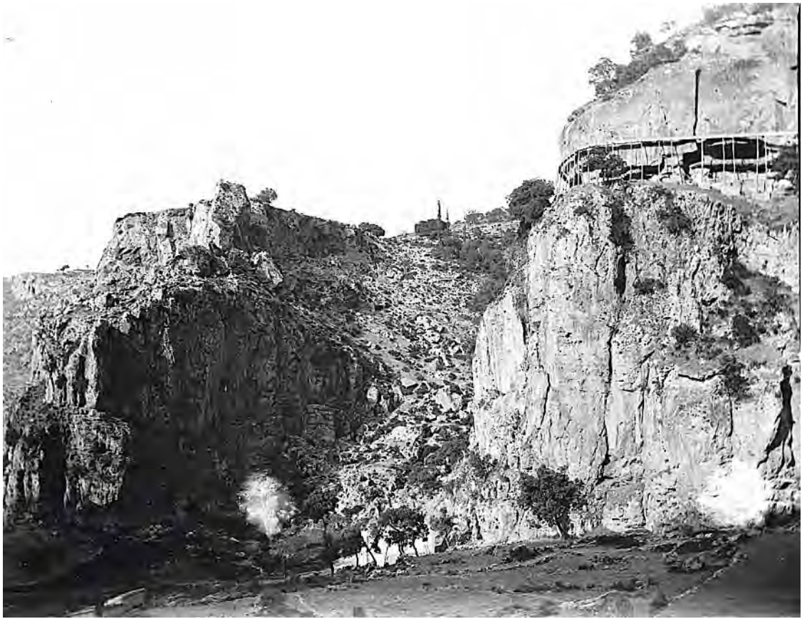
Fig. 114.- El Abrigo de Los Batanes a inicios del siglo XX con las canalizaciones de madera (Hacia 1910)
