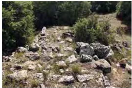
Fig. 40.- Coronación de un tramo de la muralla del sector oriental
