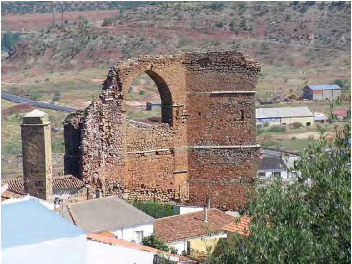
Fig. 118.- Restos del acueducto de Alcaraz
