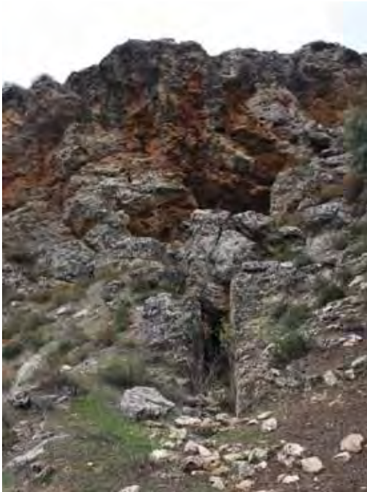
Fig. 115.- Canalización en la roca a la altura de La Molata, para la conducción del agua desde el nacimiento del pueblo, en el arroyo de La Mesta
