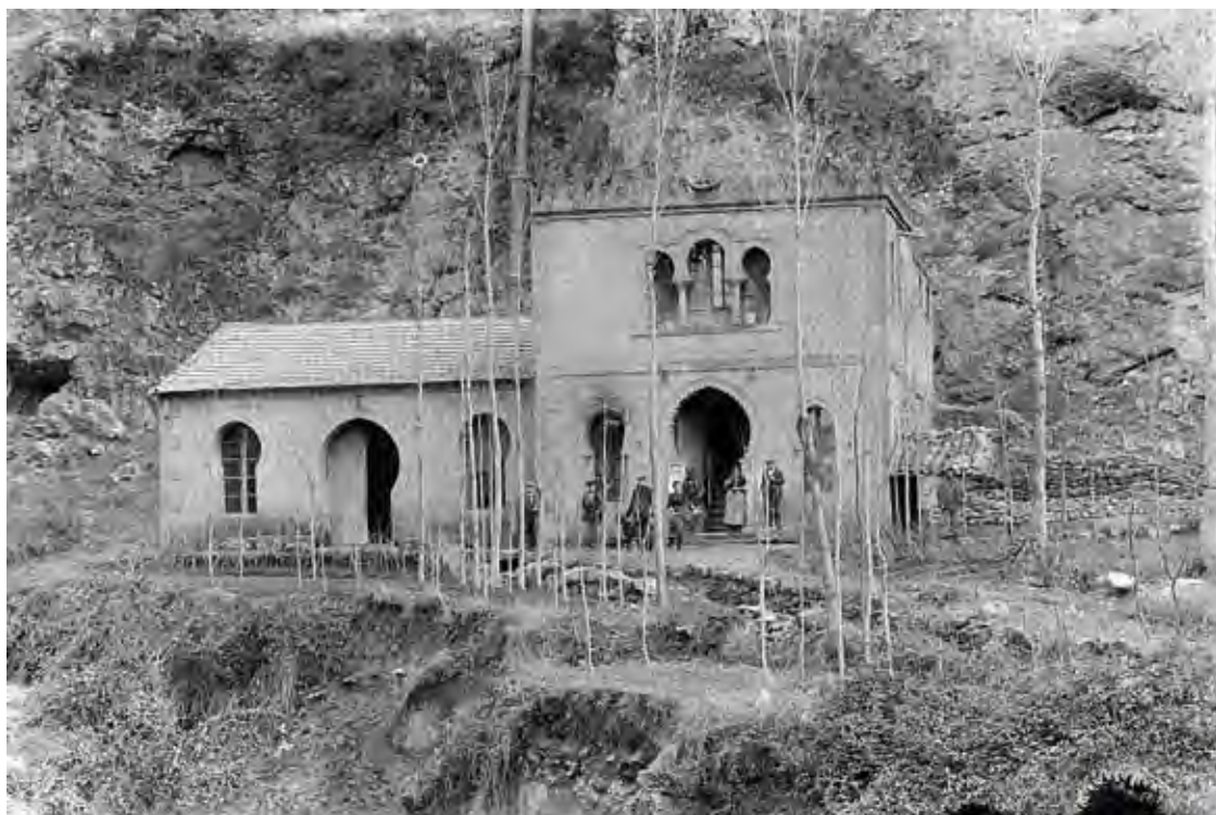
Fig. 119.- Vista de la central hidroeléctrica a principios del siglo XX (Biblioteca Digital de Castilla La Mancha. Fondo Fotográfico Luis Escobar, ES.4516&AH. Hacia 1925)
