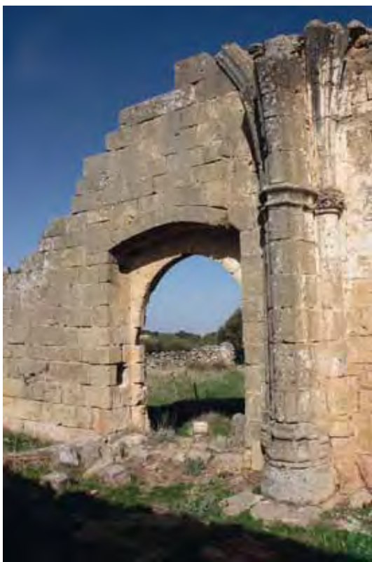
Fig. 77.- Vista interior de la portada principal de la Ermita de El Salvador
