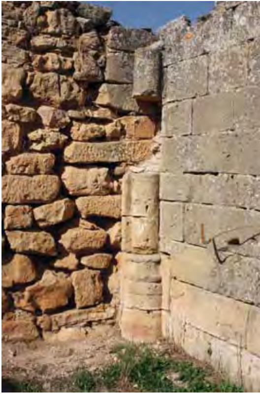
Fig. 81.- Pilar interior de los pies de la Ermita de El Salvador
