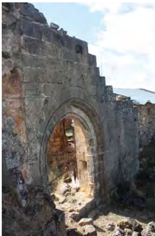
Fig. 75.- Vista de la fachada exterior y la puerta principal de la Ermita de El Salvador
