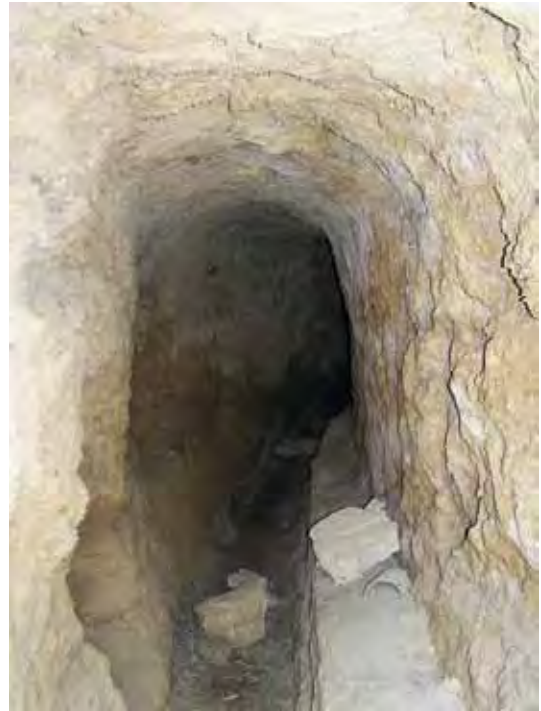
Fig. 116.- Conducción subterránea a la altura de La Molata, para la conducción del agua desde el nacimiento del pueblo
