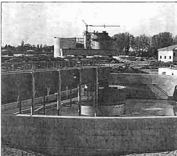
La depuradora tendrá que tratar vertidos adecuados. LA VERDAD
