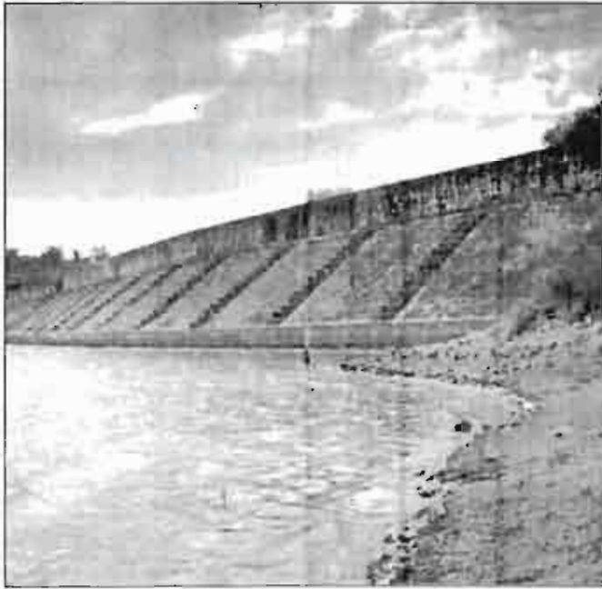
Hace falta construir nuevos embalses que recojan el agua sobrante en época de lluvias.
