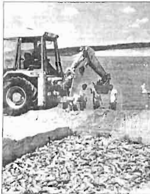
Una zona del Pantano de Alarcón terminada en la "zona común".
