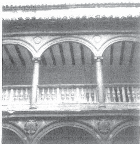
Segundo piso, en el que se repite el esquema de la planta baja, con una balaustrada.
