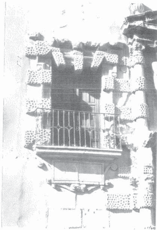
Balcón lateral de la fachada, en cuya base encontramos unos típicos elementos decorativos -cartelas-, semejantes a los diseñados por Serlio en su libro IV
