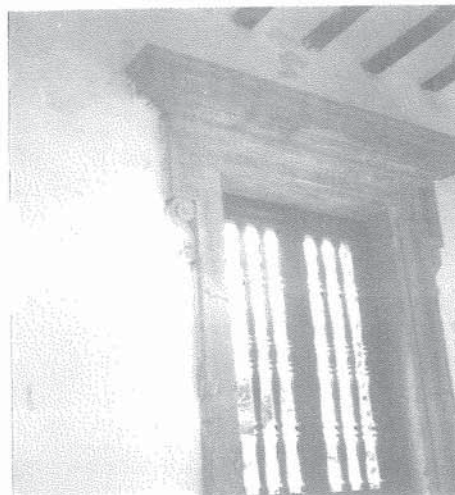
Portada del Oeste que da acceso al jardín, en la que destaca un gran dintel y jambas con molduras en acodo en las que se colocan ménsulas dispuestas lateralmente
