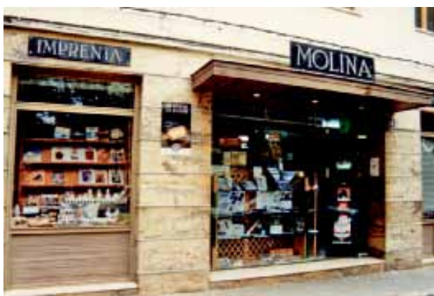
Fig. 32: Fachada del establecimiento.
