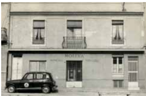
Fig. 31: Imagen de la fachada de la imprenta en la calle Mendizábal.
