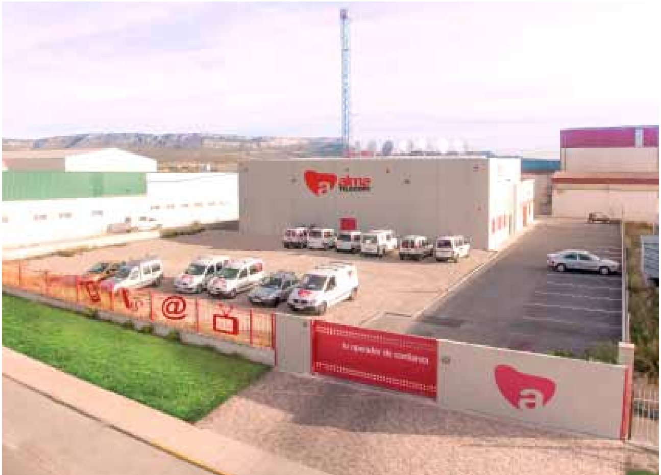
Fig. 31: Edificio del Centro de Datos de Alma Telecom en el polígono industrial en 2012.
