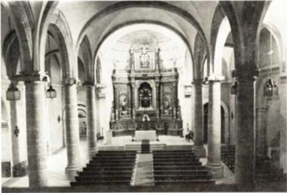
FOT.3-- TARAZONA. Parroquia de San Bartolomé. Interior hacia la cabecera.
