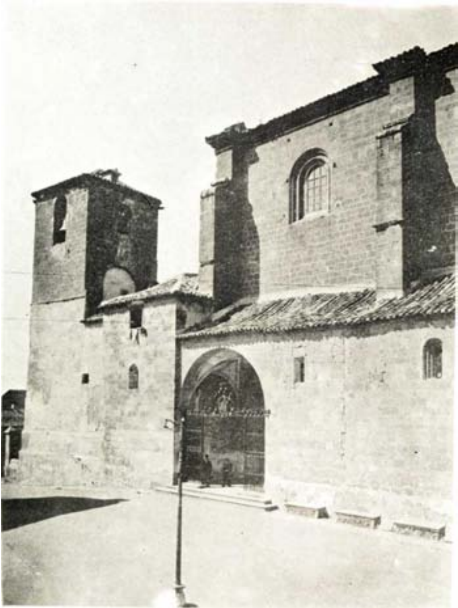
FOT.10- ALBACETE. San Juan Bautista. Parte Sur. A la izquierda observese parte de la obra primitiva. El primer cuerpo de la torre de tapial el segundo de silleria. (Fot. del Roa)
