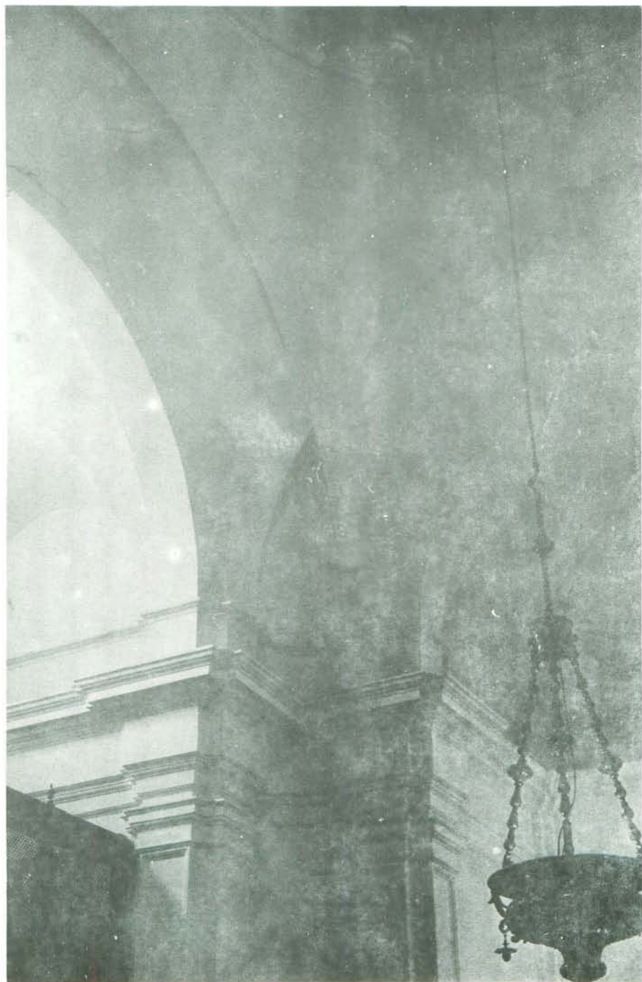
FOT. 8. -LOS LLANOS, Ermita de San Pedro de Matilla. Detalle de las bóvedas. Obsérvese los arcos cruzados y revirados.
