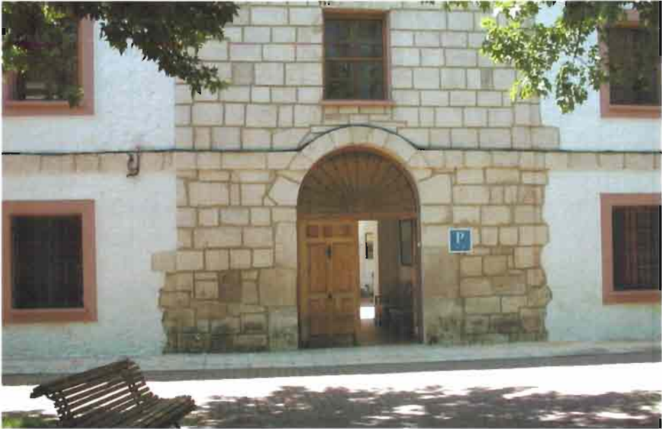
Fachada principal del Balneario. (Gentileza de Ismael Civera Alcañiz)
