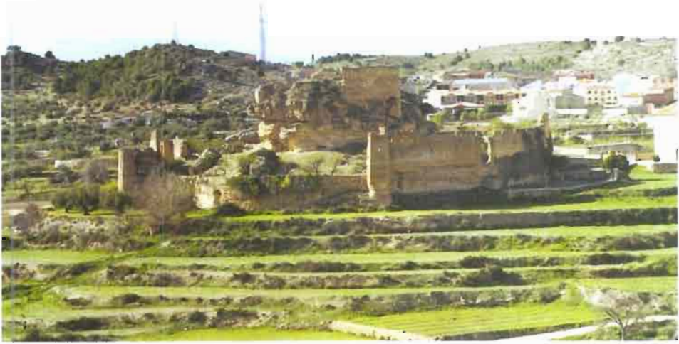
LÁMINA III.- Vista del complejo fortificado desde el Este.
