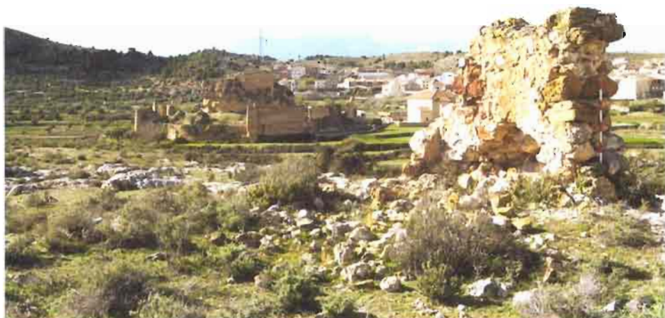
LÁMINA XIII.- Estructura cuadrangular de "El Cabezo".
