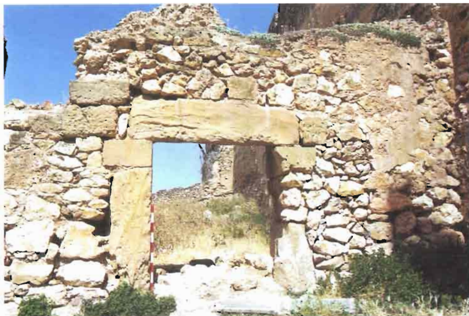
LÁMINA XI.- Estructura adintelada adosada al recinto externo en su extremo Norte.
