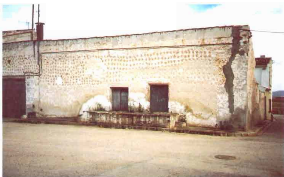
3.2 Bodega en Zulema (Alcalá del Júcar).
