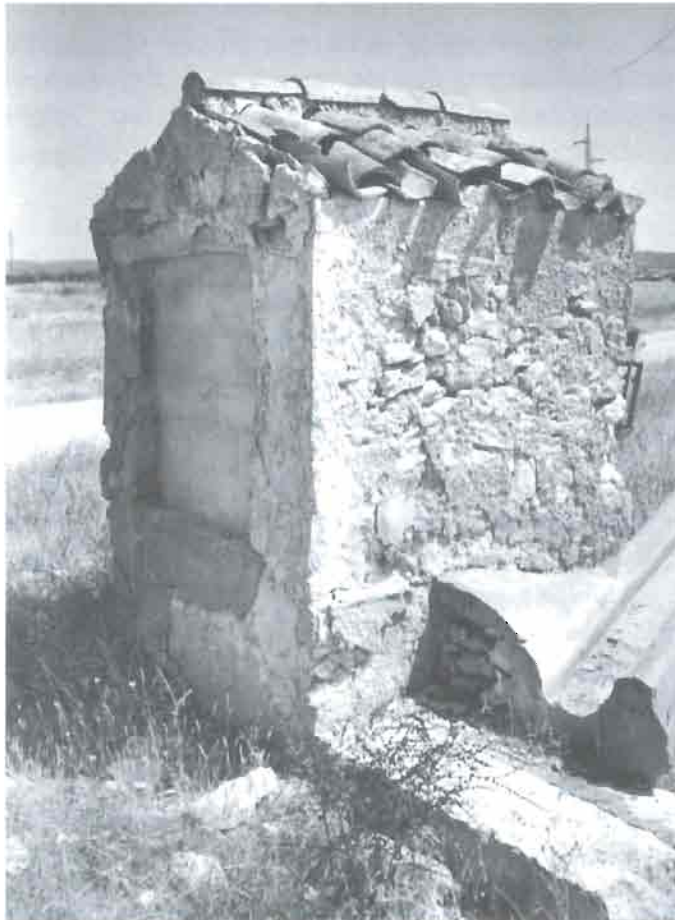
5.1 Aljibe con cubierta de teja en las Casas del Cerro.
