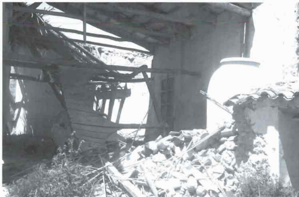
3.3-2 Restos de la estructura o altillo que facilitaba el acceso a la boca de las tinajas (Marimínguez, Alcalá del Júcar).
