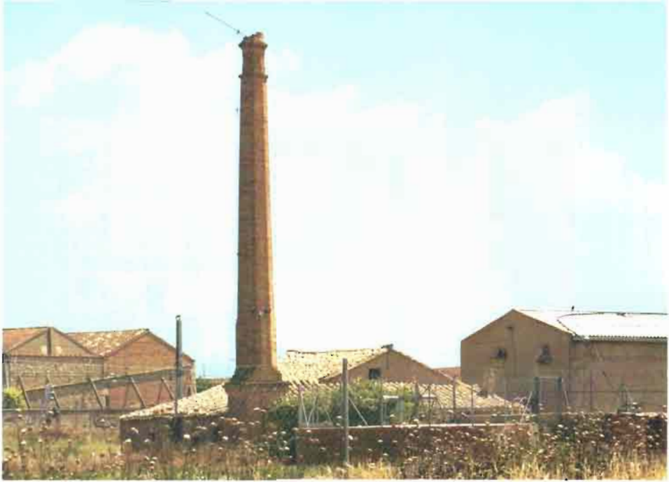
Fot. 67.- La Roda. Chimenea industrial. Fábrica de pastillas.
