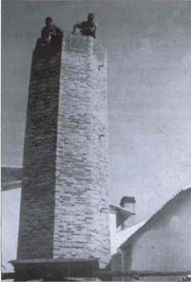
Fot. 5.- Fuste. Chimenea industrial
