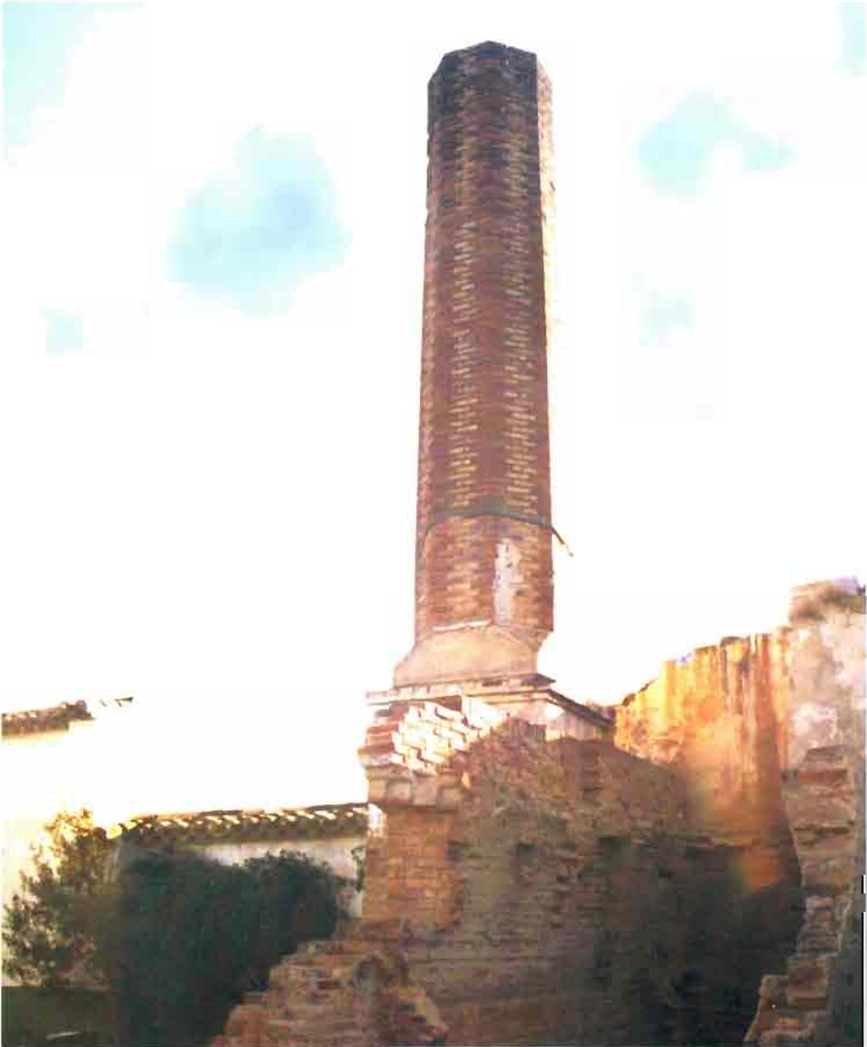
Fot. 27.- Casas Ibañez. Chimenea industrial
