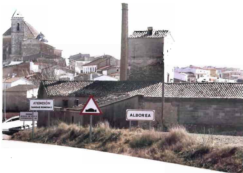
Fot. 50.- Alborea. Chimenea industrial. Fábrica de Alcohol
