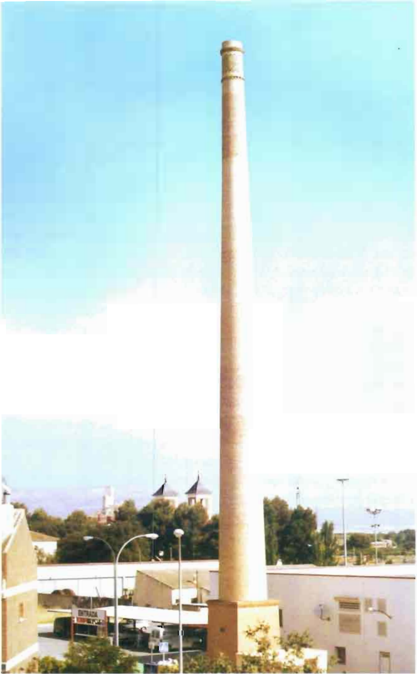
Fot. 19.- Almansa. Chimenea industrial
