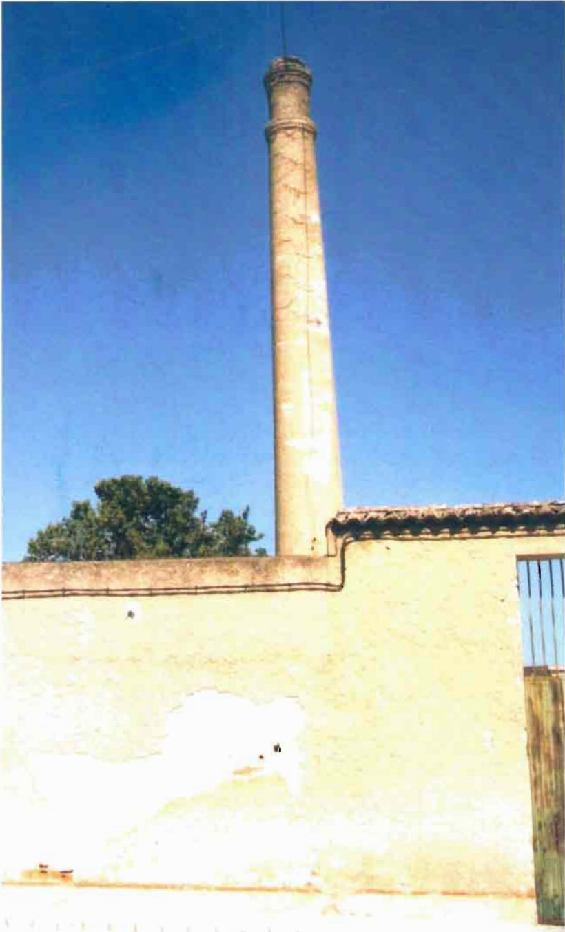
Fot. 32.- Hellín. Chimenea industrial
