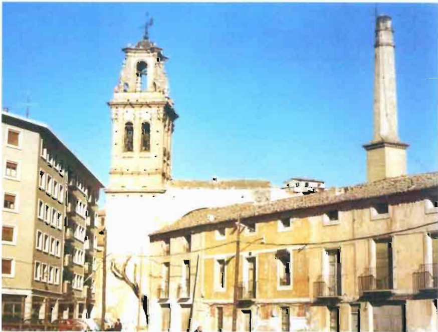
Fot. 52.- Almansa. Chimenea industrial. Fábrica de jabones de la familia Rodríguez
