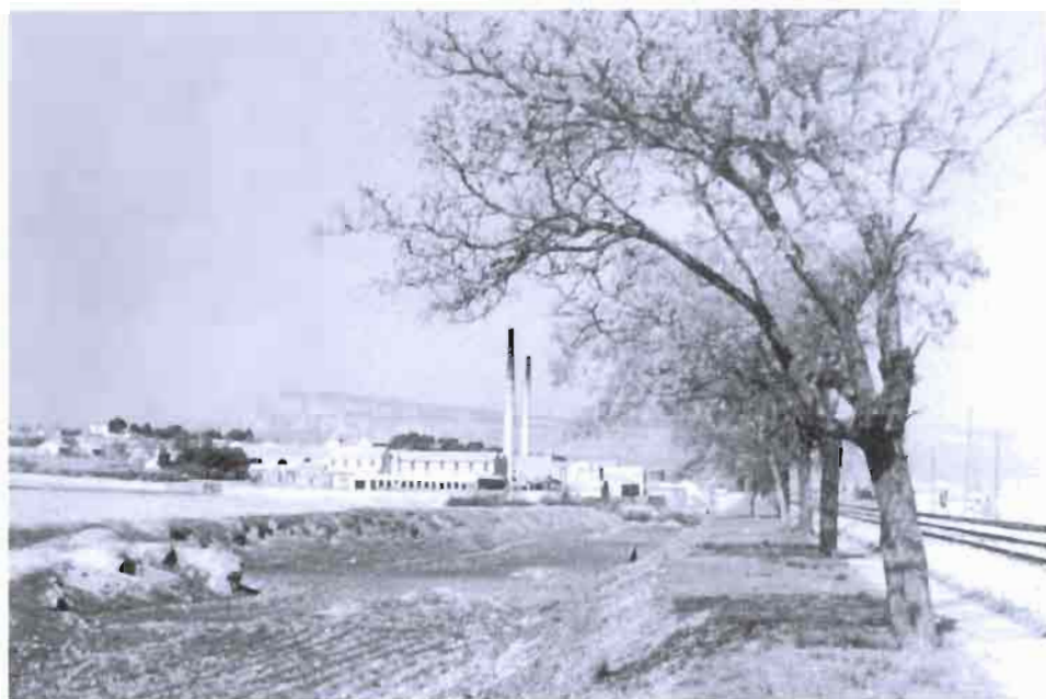
Fot. 55.- Almansa. Chimenea industrial. Cerámica Collado (C/ Buen Suceso).
