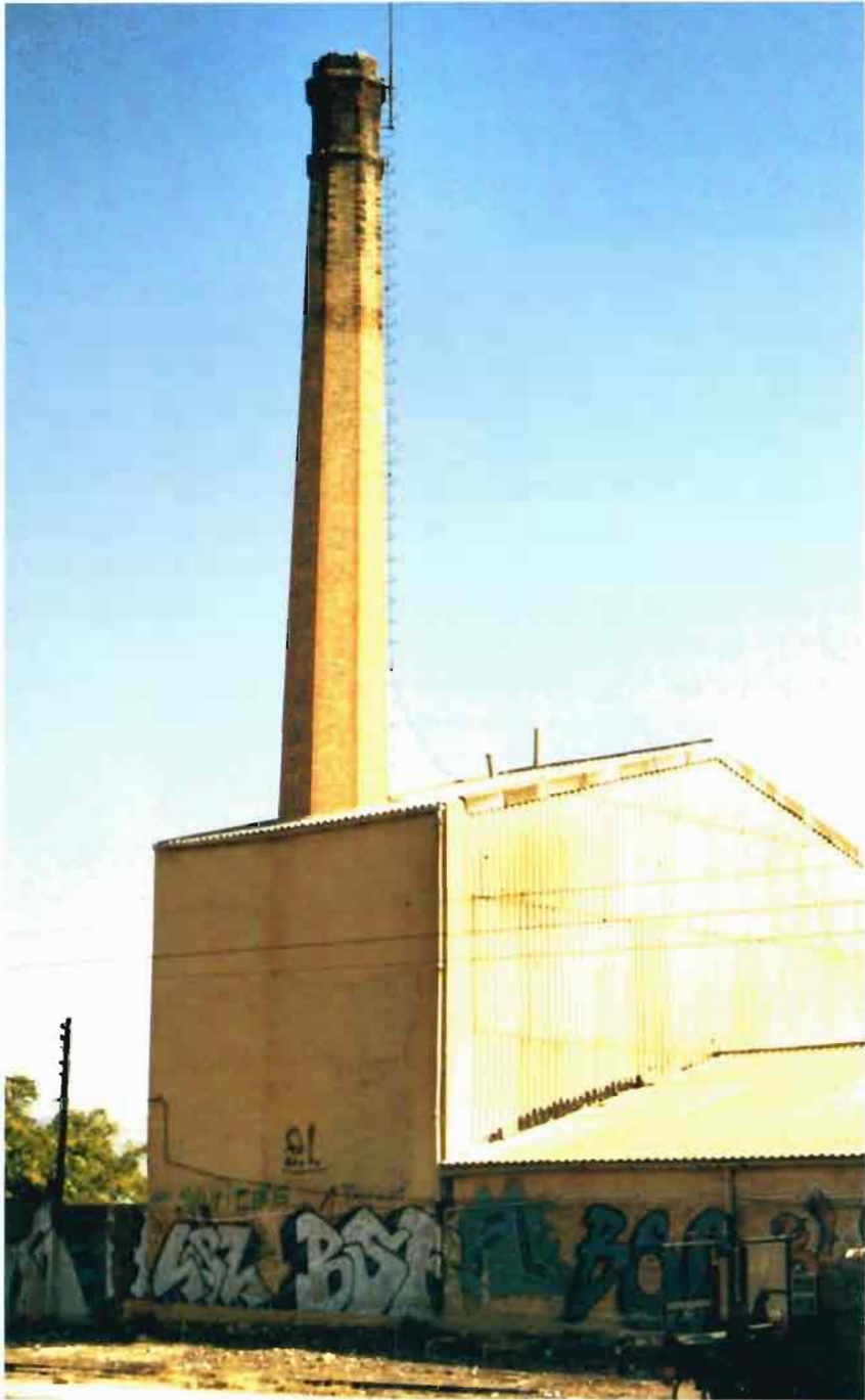
Fot. 22.- Almansa, Chimenea industrial
