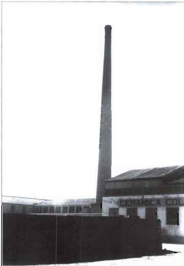
Fot. 18.- Almansa. Chimenea industrial
