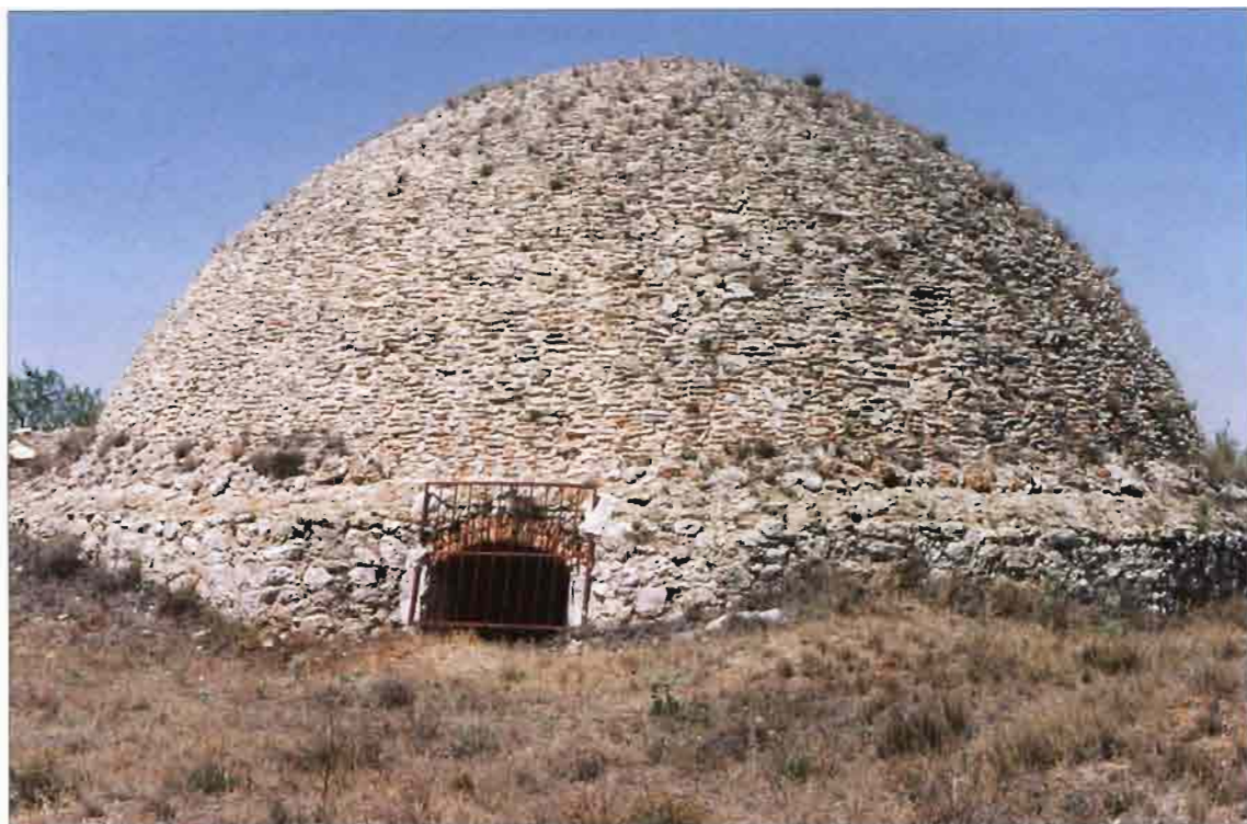
FOTO 3 ► El pozo de la nieve visto desde el Suroeste
