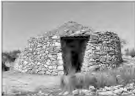
Foto 2.- Cuco de Pedro Sánchez. Como los demás, está orientado al sur, previniendo los vientos fríos del norte, y mira hacia el pueblo, configurando una de las vistas más hermosas por su emplazamiento. En su interior encontramos un banco, una chimenea y una alacena, y en su exterior una poceta de un metro y medio de profundidad, sin duda para recoger el agua de lluvia. Su intervención ha sido muy intensa por la peligrosidad de derumbe en la parte frontal e izquierda.
