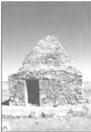
Nº 165 "Gallinero". Casas de Ves
