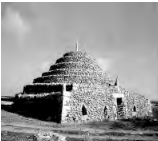
Foto 6.- Construcciones de utilidad ganadera
