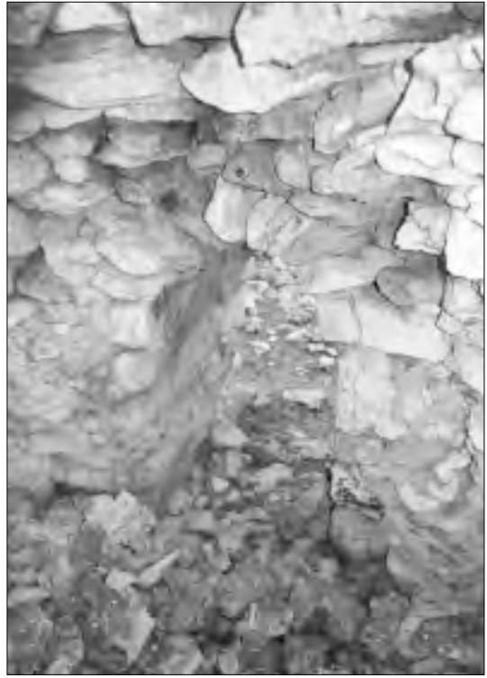
Número 29. Detalle del cierre interior de la puerta mediante el uso de dovelas.
