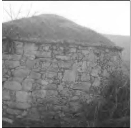
Fig. 3: Detalle de paramento y cornisa.
