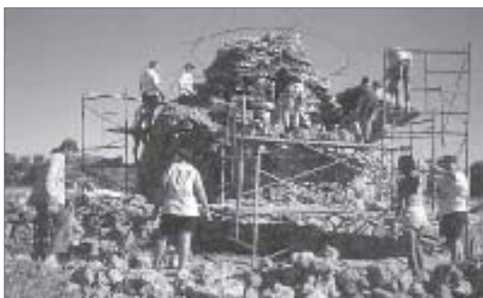
Foto 3.- Chozo "La CabaÑona". Proceso de rehabilitación. 1998
