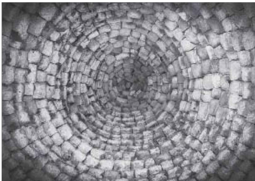
9. Detalle de la técnica constructiva utilizada en las barraques de bestiar más elaboradas. La cubierta, en forma de peonza invertida, está construida por aproximación de hiladas de piedras perfectamente trabajadas y ensambladas entre sí.
