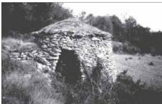
Foto 2. Esta barraca de planta circular se encuentra adosada a un margen. Se puede observar la estructura adintelada de la puerta, soportada por un arco ligeramente apuntado (Calders- Bages).
