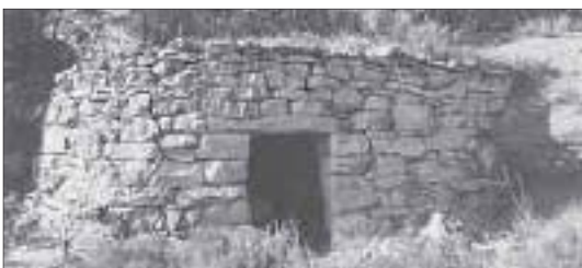
Cabaña cubierta con losas
