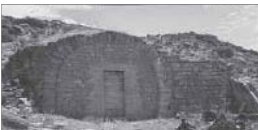
Cabaña cubierta con bóveda rebajada
