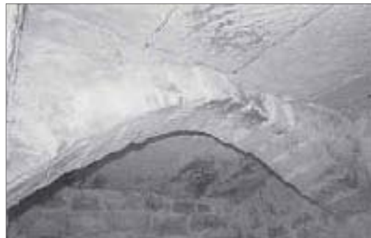
Cubierta con arco y losas
