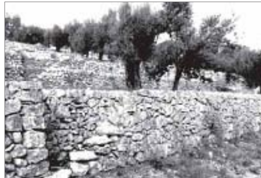
Tortosa. Muro con escalera adosada.
