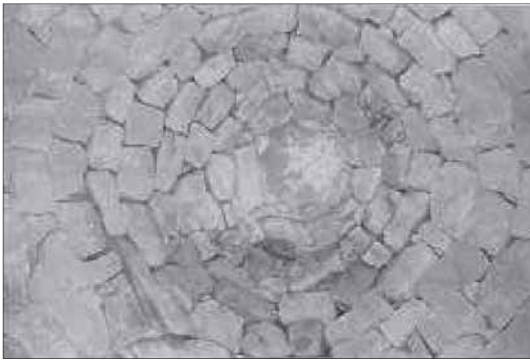
Cubierta de falsa cúpula
