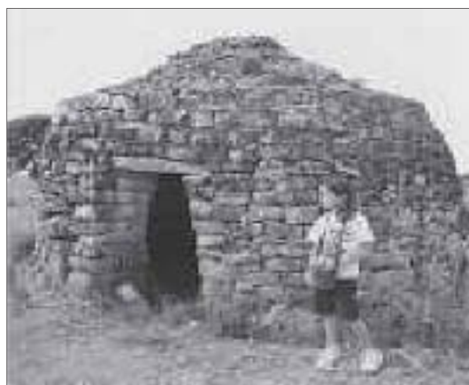
Cabanes cubiertas con falsa cúpula
