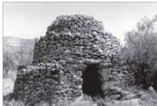
El Godall. Barraca de paredes retranqueadas.
