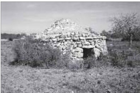
B-8, Tanques den Descalcé
