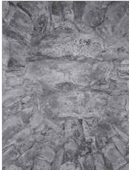
Cubierta de losas
