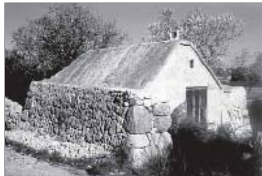
Barraca de establidor con cubierta truncada
