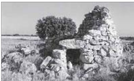
Foto 1.- Chozo (sin nombre). Estado de conservación: en derrumbe.
