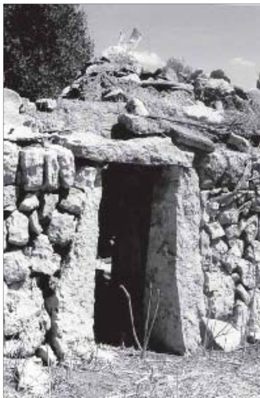
Portal de una “barraca de roter” de jambas monolíticas y una losa como dintel.
