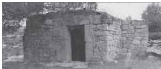
Cabaña cubierta con arco, jacenas y losas
