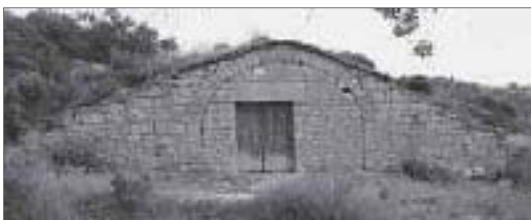
Cabaña cubierta con bóveda de cañón
