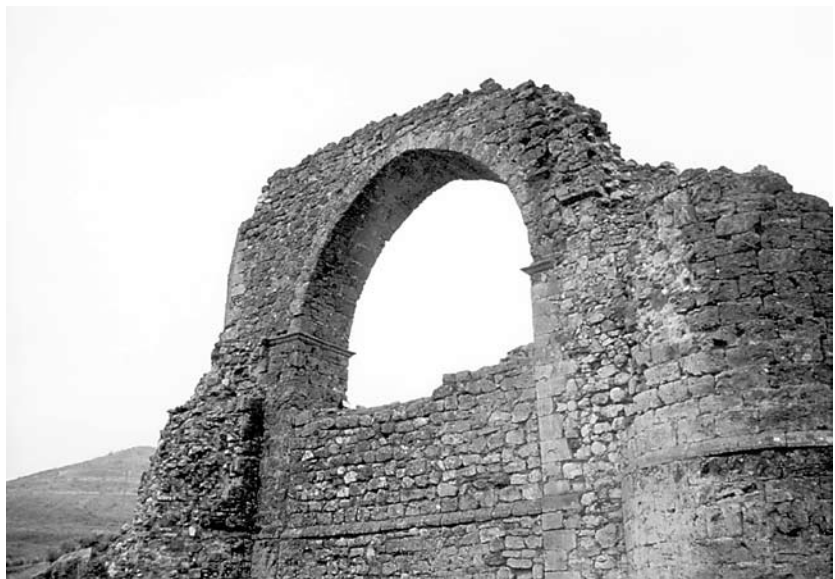
Acueducto de Alcaraz
