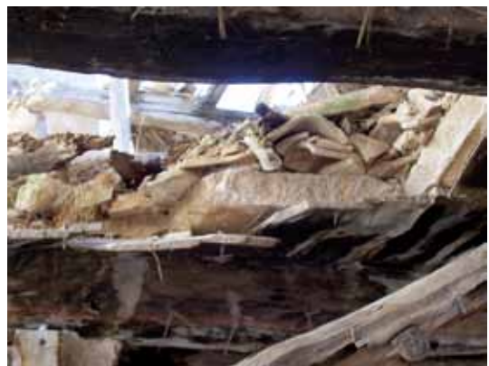
Entrevigado con tablero de madera. Solado con mezcla de yeso y tierra compactada. Vivienda de los Nuevos
