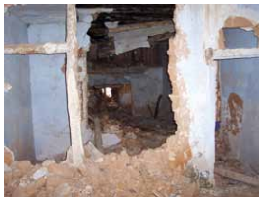
Soportes de rollizo bajo viga con doble función. Estructural y de partición
