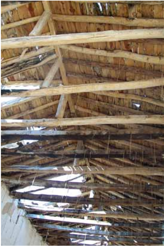
Cerchas de la cubierta de la vivienda de Los Nuevos
