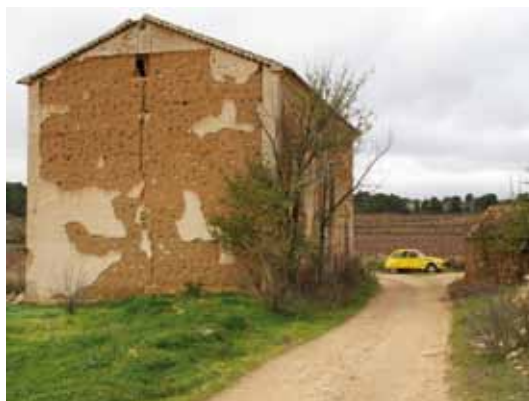
Casa de Gabaldón. Término de Villalpardo. Espectacular tapia de unos once metros de altura
