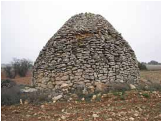
La forma de construir la cúpula de la calera era similar a la construcción de chozos. El Gordito. Jorquera
