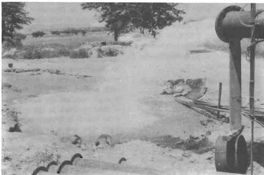
Bombeo de ensayo «Venta Galopas» (Almansa)
