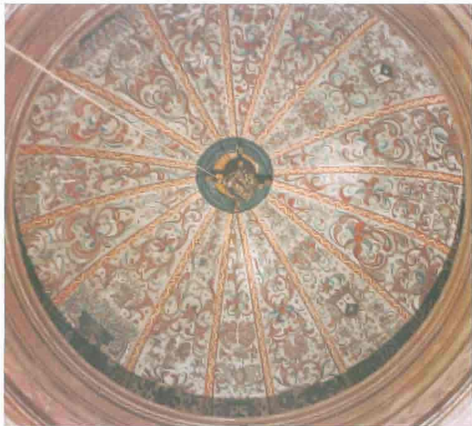
Fot. 26. Ermita de Santa Ana, Tarazona de la Mancha. Capilla de San Antón. Detalle de la cúpula. (Fot. J. Sánchez Ferrer).
