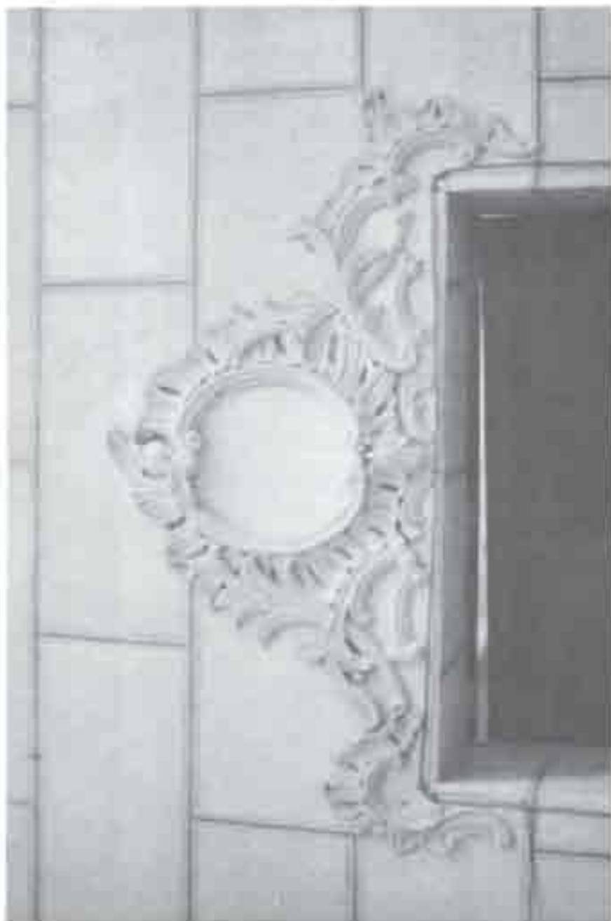
Lám. 5. Ferrniquera de San Juan Bautista. Interior. Tarja de nichillo sobre una puerta.
