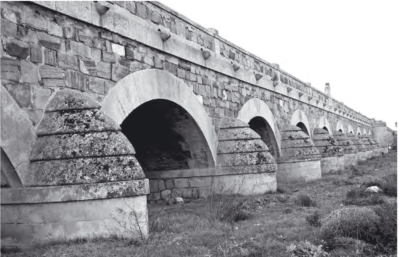
4. Puente de la Vega de las Barracas. Fotografía: M. J. Pereda Hernández.
