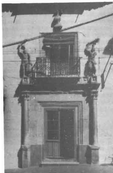
Fig. 15.- Antigua Casa de los Galianos. Alcaraz.
