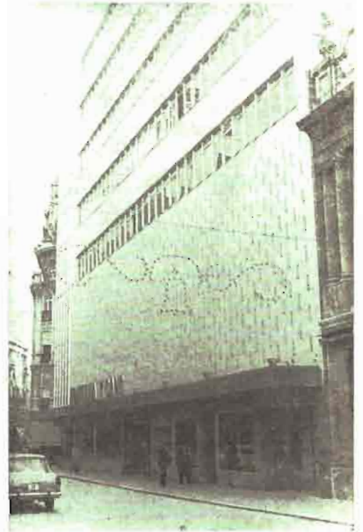
Otra calle conflictiva, la de Tesifonte Gallego
