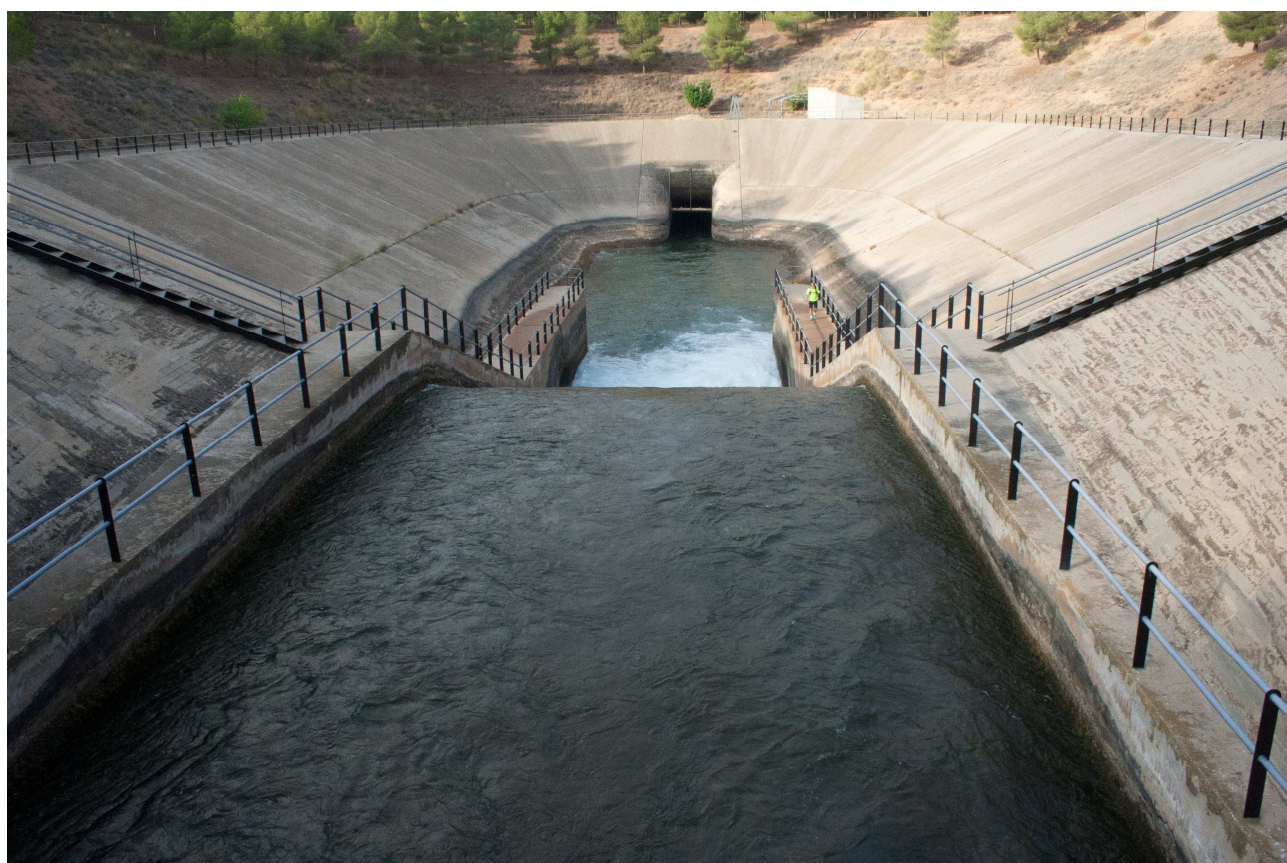
Túnel del Talave. Acueducto Tajo-Segura, Los Anguiles
