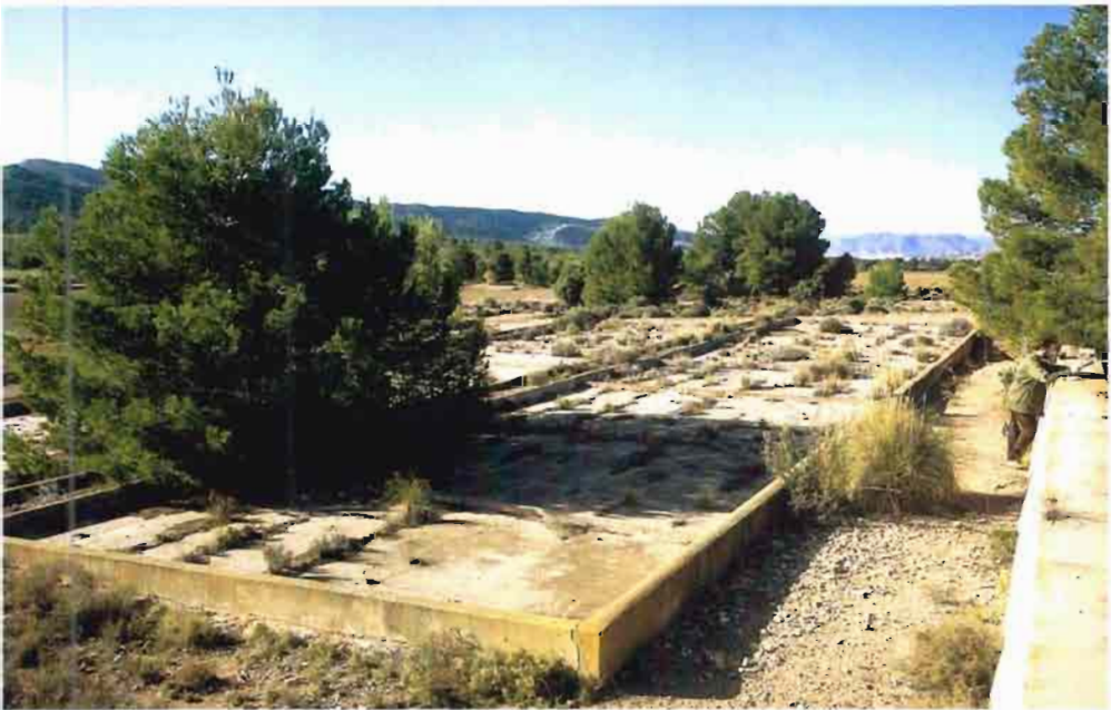
Foto 2: Vista general del salero nuevo, con sus grandes eras.
