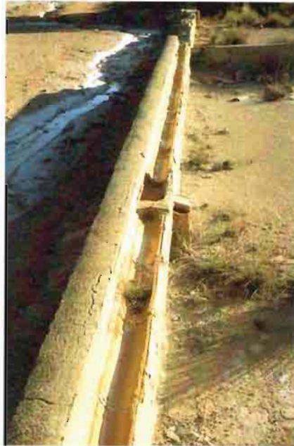
Foto 4: Detalle de las canalizaciones de las eras en el salero nuevo.
