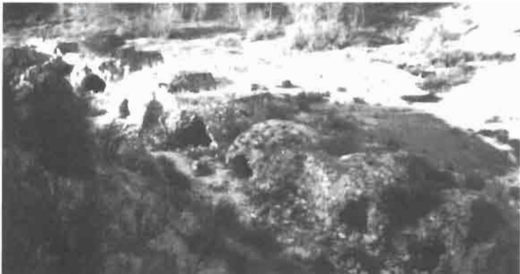
Fig. 10: Grupo de hornos Claret de primera fusión del azufre, en las antiguas explotaciones del Cenajo.
