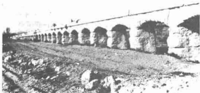
Vista parcial desde el lado Sur.
