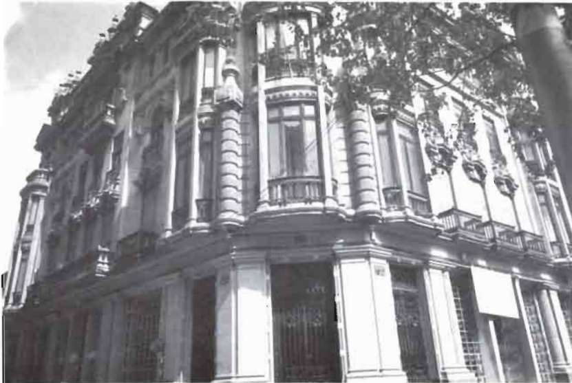
Casa nº 13, Paseo José Antonio (Banco Exterior)
