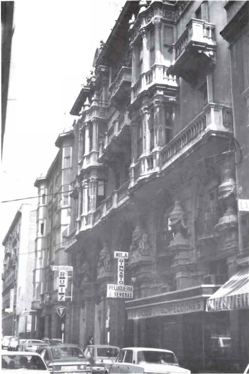
PASAJE LODARES (Fachada, C/Tinte)
