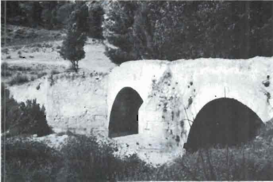
Puente número 1.- Vista desde aguas abajo. Detalle de la plataforma Sur.
