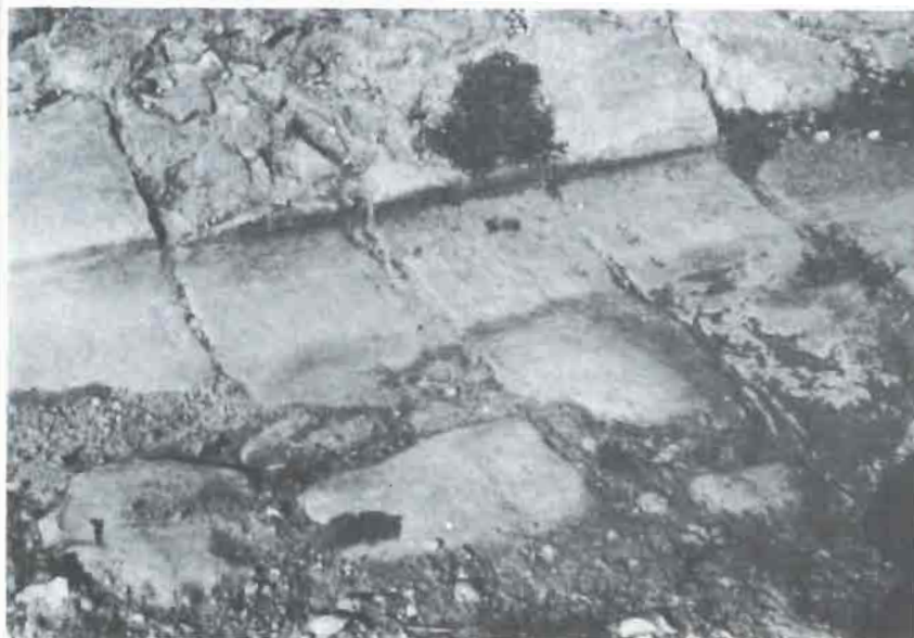
Puente número 1.- Vista de la calzada romana antes de iniciarse las labores de limpieza. Únicamente era visible la parte fotografiada.
