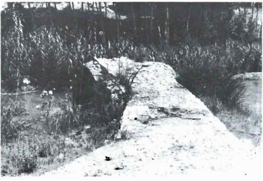
Puente número 2.- Vista Sur del puente. Obsérvese el camino formado por la argamasa y los cantos rodados. Se trata de una verdadera calzada.
