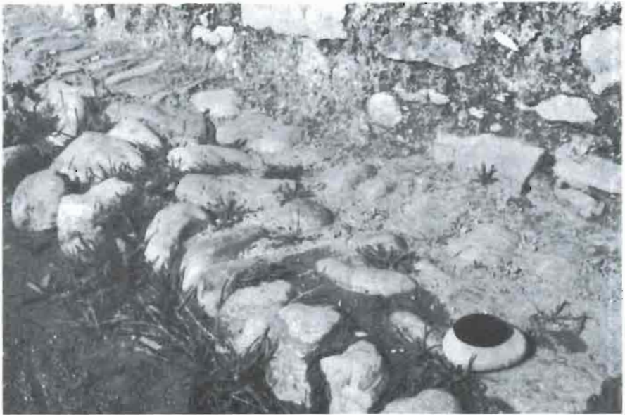
Puente número 1.- Detalle de la calzada de cantos rodados.
