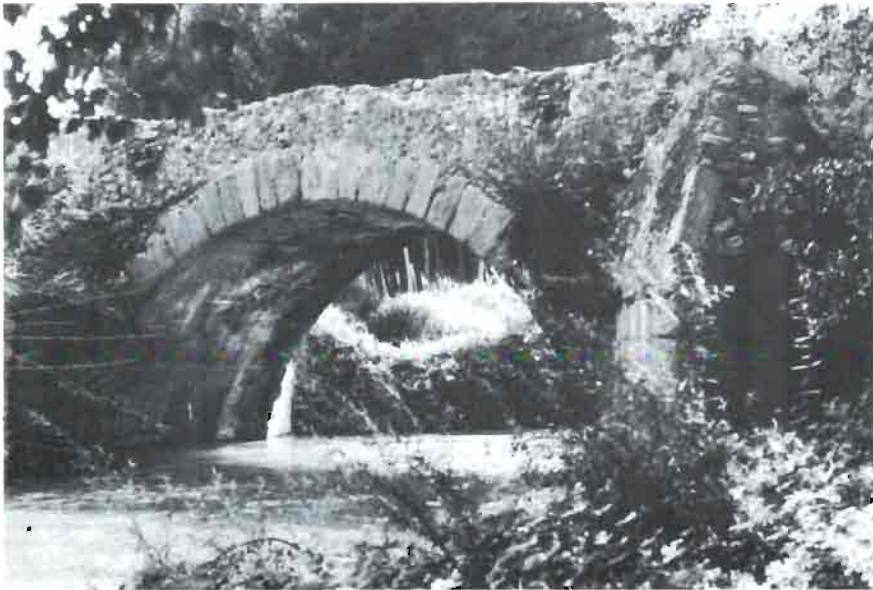
Puente número 1.- Vista del arco principal más septentrional. (Aguas arriba)
