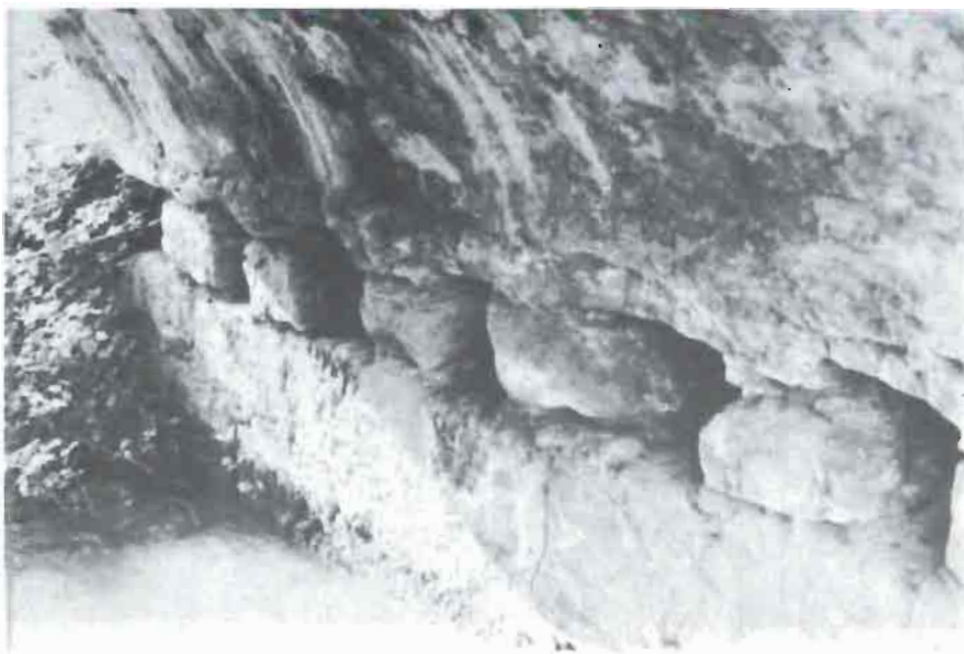
Puente número 1.- Detalle del interior de la bóveda del arco pequeño.
