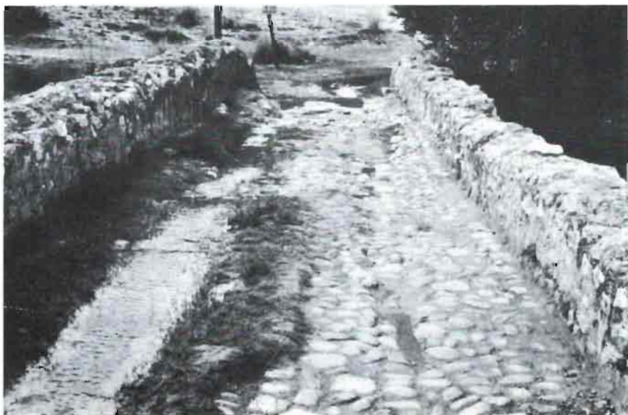
El pavimento de cantos rodados en primer término. Al fondo la calzada de losas en disposición horizontal.
