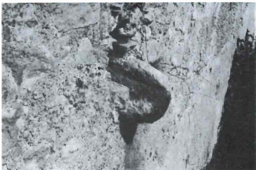
Vista de una de las canaleras de desagüe.
