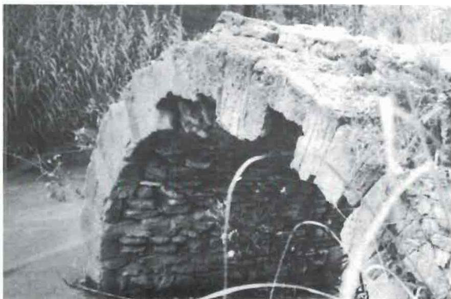
El puente número 2 visto desde aguas arriba. Obsérvese la diferencia entre la bóveda y el trasdos con las irregulares dovelas.
