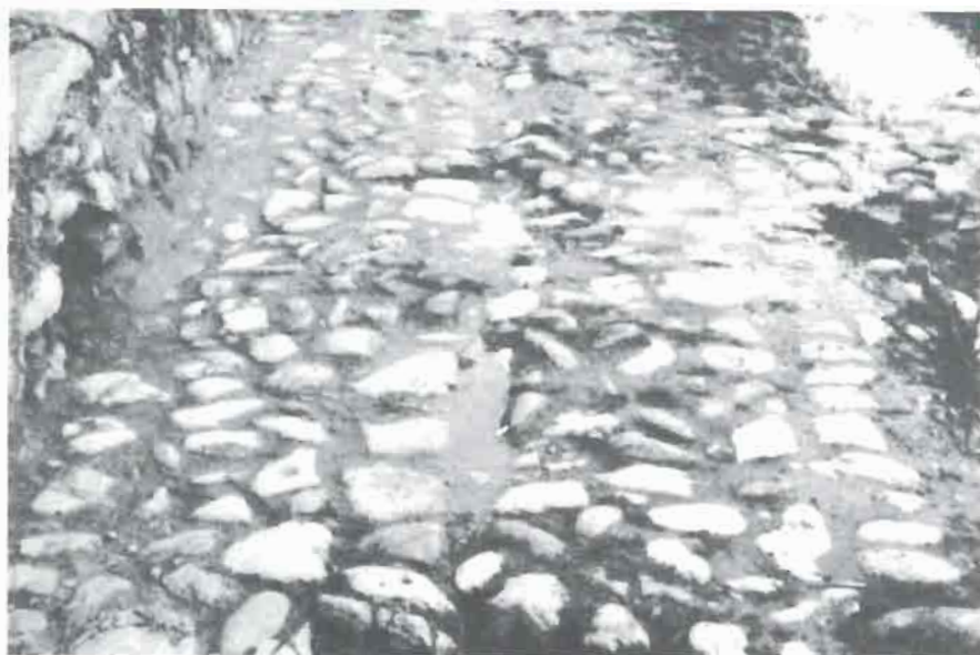
Detalle del pavimento de cantos rodado.
