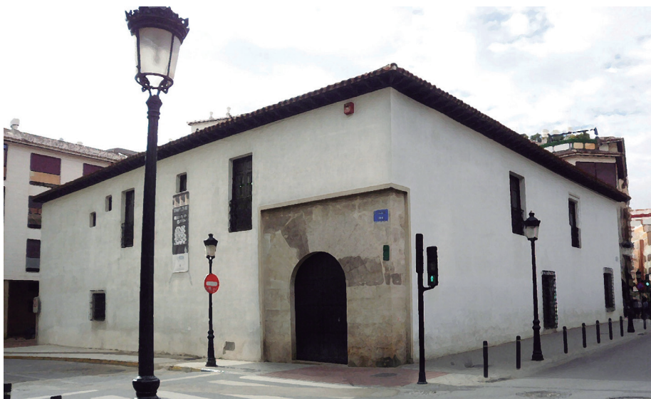
Figura 1. Puerta de acceso con arco de medio punto y anchas dovelas a la posada del Rosario en la calle del Tinte. Fotografía: Manuel López Collado.
