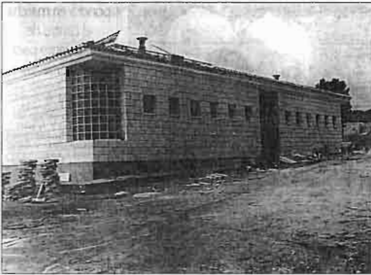
Imágenes del estado de las obras del aula de la naturaleza. (FOTO ANA MARIA)
