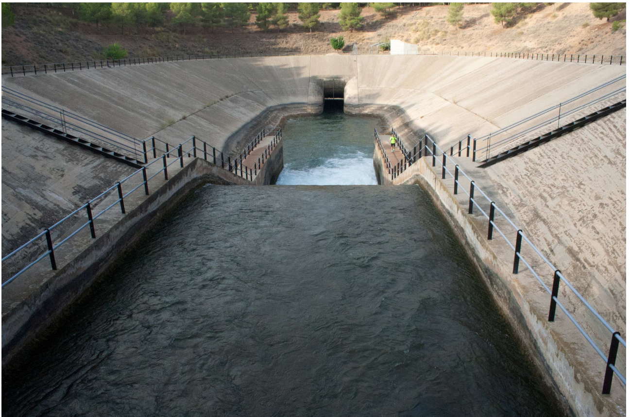
Túnel del Talave. Acueducto Tajo-Segura, Los Anguiles
